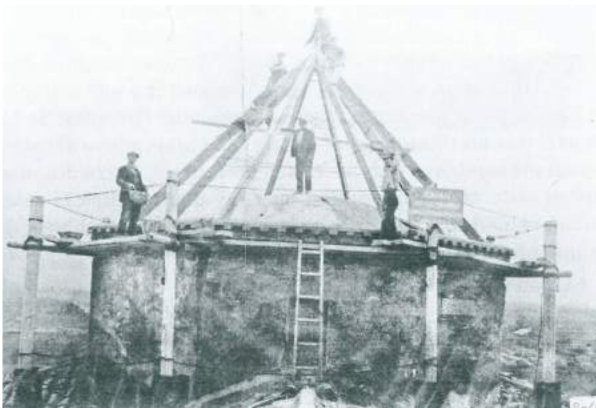
Restauració del cimbori, l'any 1929
