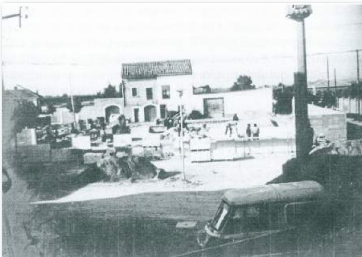
Inici de la construcció del poliesportiu
